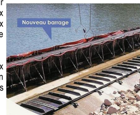
On a réalisé un nouveau barrage sur la petite Saône tout en conservant l'ancien barrage escamotable à aiguilles construit en 1834 par l'ingénieur Antoine POIREE sur 220 m, divisés en 4 passes de 52 m qui représente 1000 aiguilles de 20 cm de large sur 1,80 m de haut.
