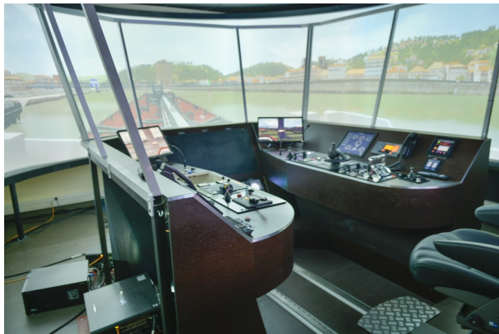
Le poste principal
