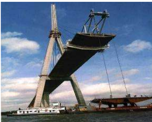
Positionnement des voussoirs du Pont de Normandie (220 tonnes).
